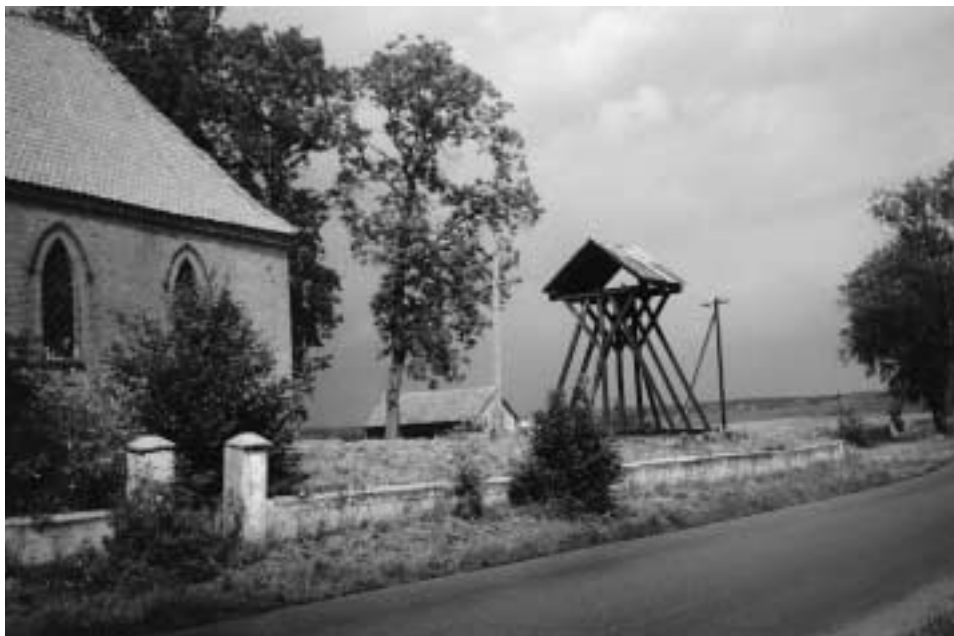
Der Glockenstuhl in Seegertswalde wurde durch Eisenträger gefestigt. Im Hintergrund das ehemalige Spritzenhaus, heute Leichenhaus.
